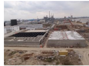
建设中的盐城联化废水一期项目
